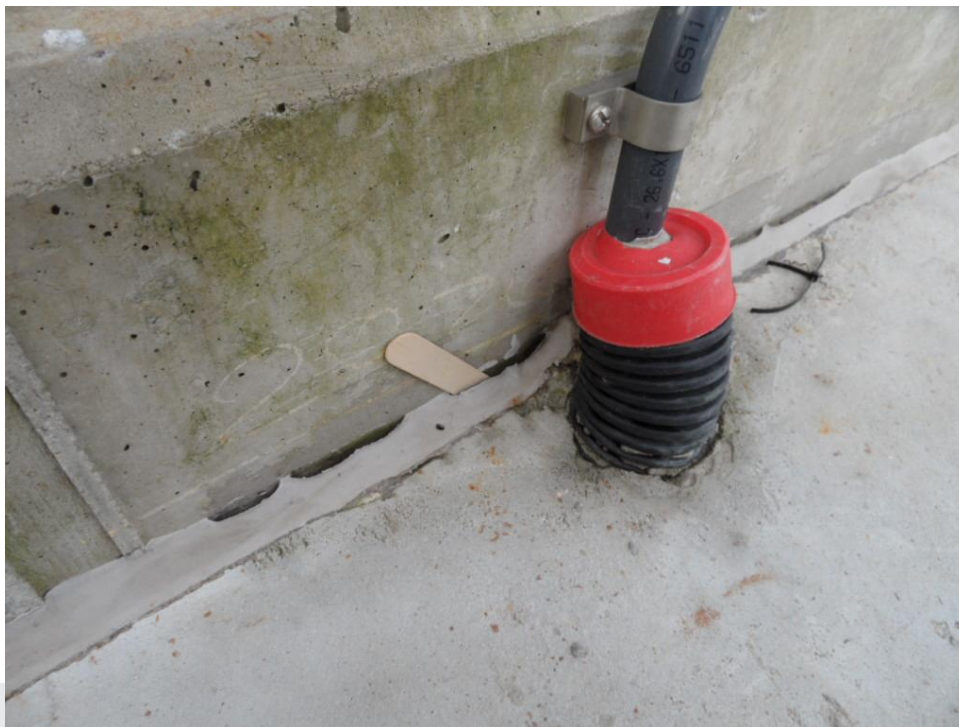
Foto: Gebrek aan afdichting.
