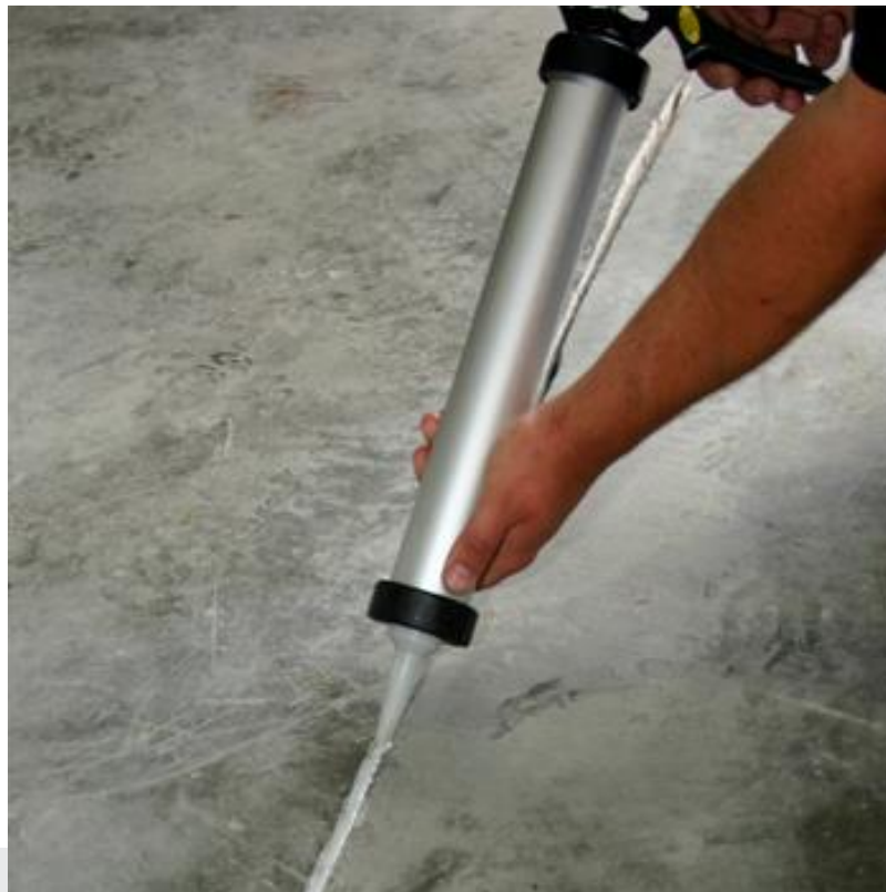
Foto: Aanbrengen voegmassa.
